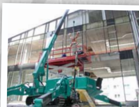
Pose de vitrages
